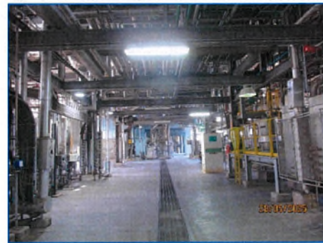
ภาพถ่ายที่ 2.2-12 รางระบายน้ำภายในพื้นที่โครงการ
